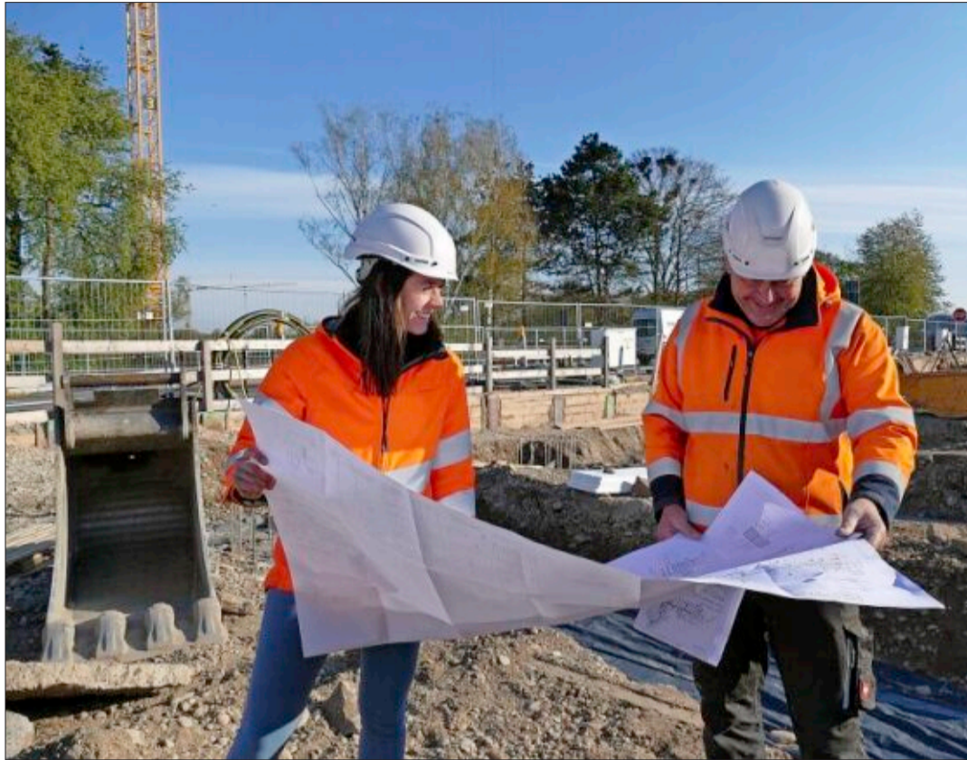
Bauingenieurin Cornelia Schwarz (l.) bei einer Besprechung auf der Baustelle
